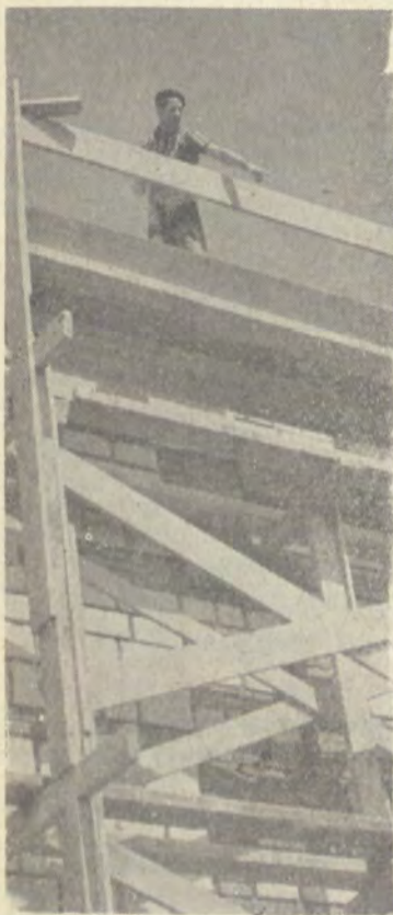
« Sul cantiere, se non dimentico l'italiano, mi mettono fuori... »
