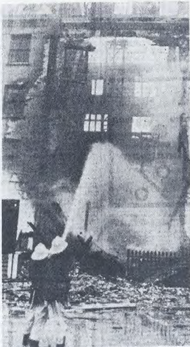
Completamente distrutto l'edificio che ospitava il consolato
