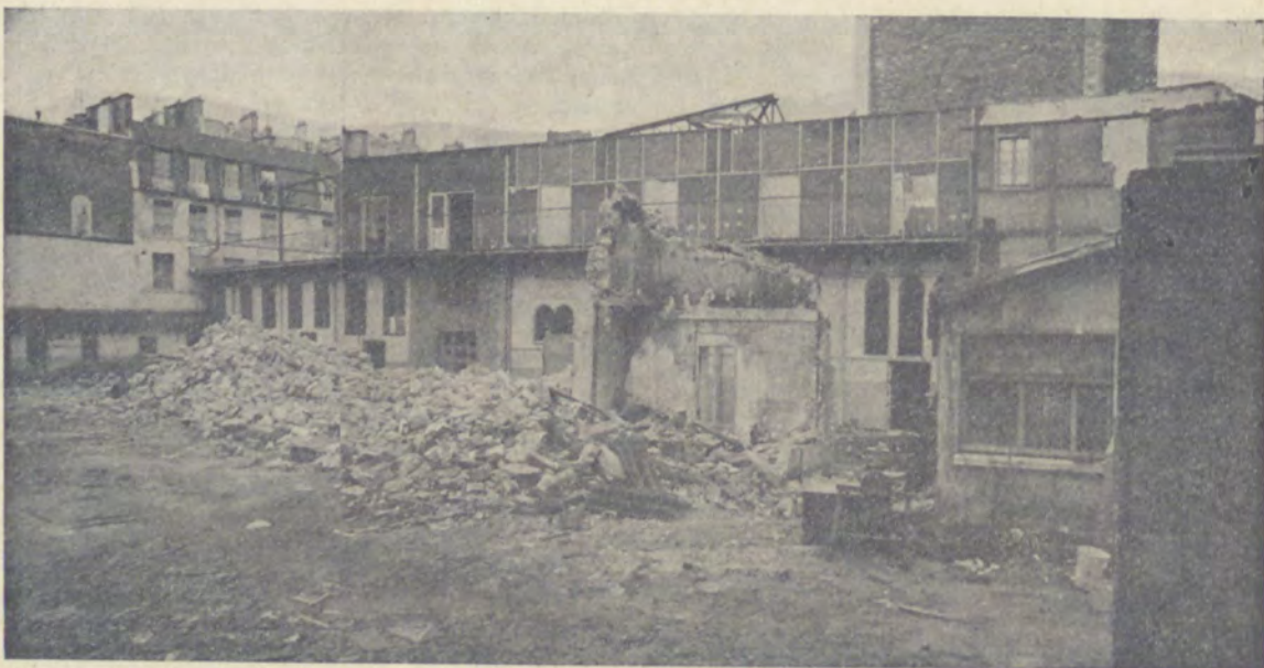
Una fase della demolizione della Missione Italiana, vista dalla rue de Montreuil.
