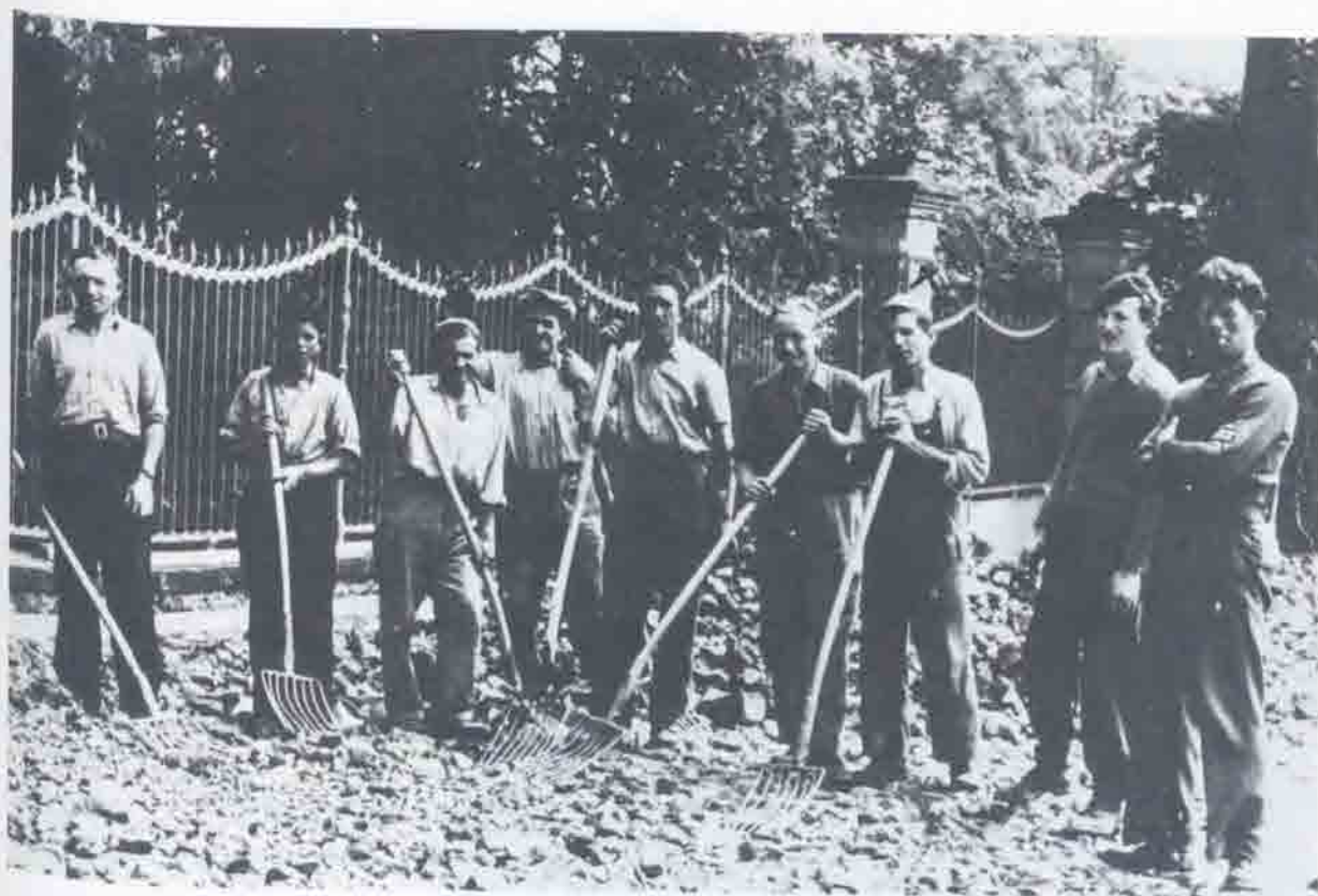
Capellen, 1953. Des ouvriers italiens et allemands construisent la nouvelle route Capellen-Luxembourg.
